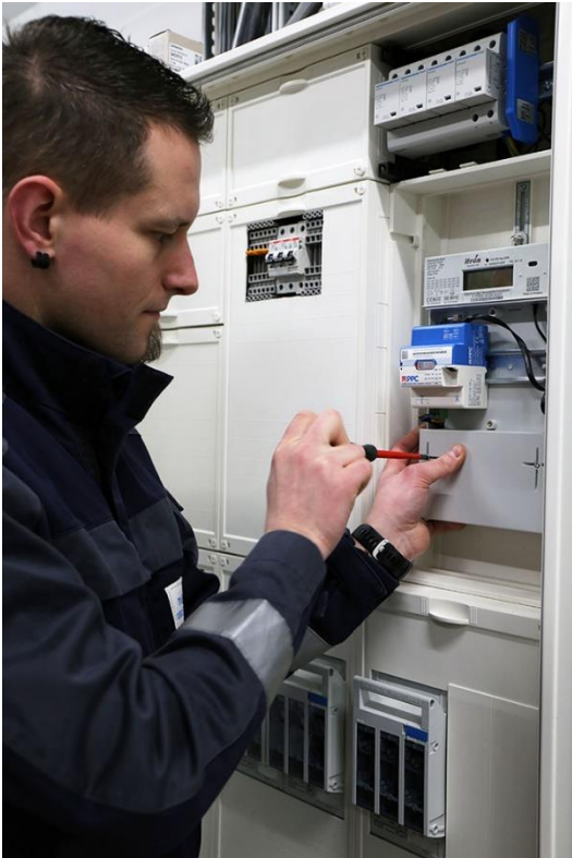
Abbildung 2: Einbau des LTE450-SMGWs (Abb. © TMZ)
