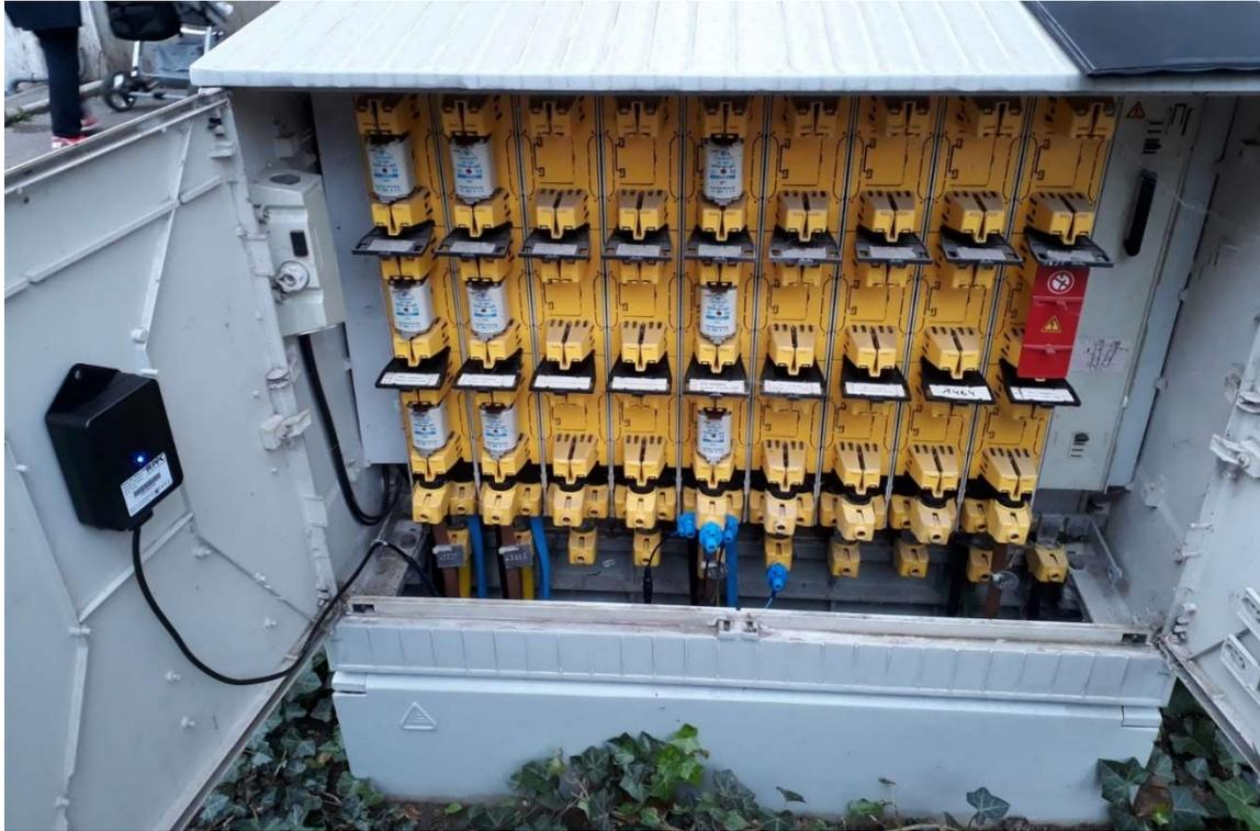
**Abb.1:** Ein Sensor BPL-Modem in einem Mainzer Verteilerkasten übermittelt aktuelle Netzzustandsdaten.
