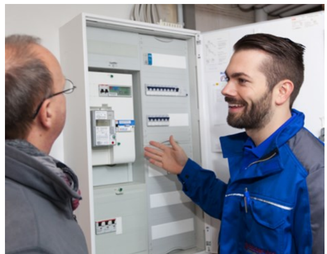
Ruven Fürniß, Mitarbeiter der Netzservice Gesellschaft, installiert bei einem Kunden PPCs Smart Meter Gateway. Bild: Jens Kolb.
